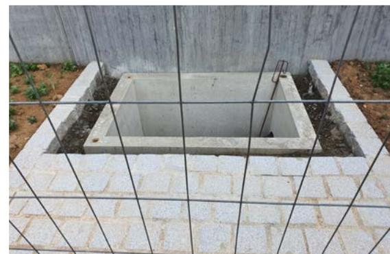
Ein Überlaufbauwerk zur Rückleitung von durchgesickertem Grundwasser in die Donau
