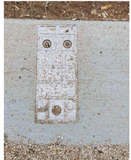
Vorrichtung der Bodenverschraubung der mobilen Hochwasserschutz Elemente
